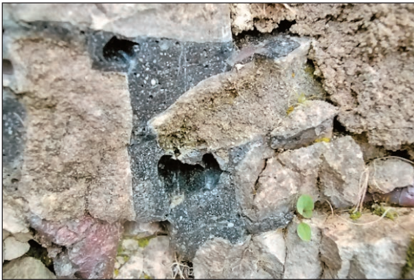
Рис.3. Витрифицированное укрепление Сент-Сюзан на северо-западе Франции. Участок стены, сложенный обломками пород, которые сцементированы пемзой. Хорошо видны неизменные обломки исходных пород и пористый стекловатый материал (пемза), образующийся при витрификации.
